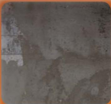
1. Aşama: Uygulama yüzeyinin temizliği ve kontrolü yapılır. Yüzey maksimum 3 cm yüzey hatasını aşmayacak şekilde olmalıdır.
