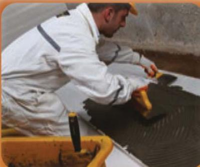
2. Aşama: Yapıştırıcı olarak 1.Sınıf Çimento Bazlı EPS Isı yalitim Levhası Yapıştırma Harcı veya PU (Poliüretan) Bazlı Isın Yalitim Levhası Yapıştırma Köpüğü ile Uygulanır.
