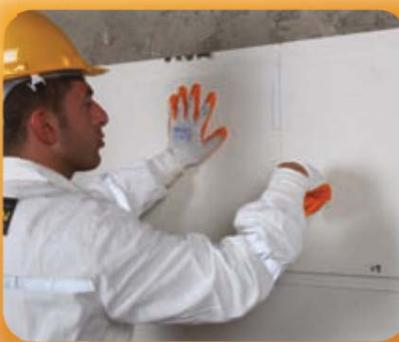
3. Aşama: Su basman profil terazisinde ve şakülünde alındıktan sonra plakalar binili sistemde yapıştırılır. Yapıştırıcı tam priz aldıktan sonra plakanın bini bağlantısına gizli dübel işlemi yapılır.
